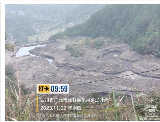
清淤工程河道现状
