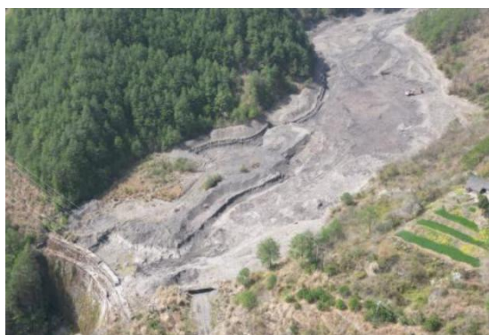
清淤起点拦渣坝现状
