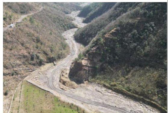
清淤终点煤矿现状
